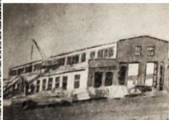
На снимке: строительство новой мастерской Безымянской машинно-тракторной станции. Фото Н. Молодцова 1956 год.
