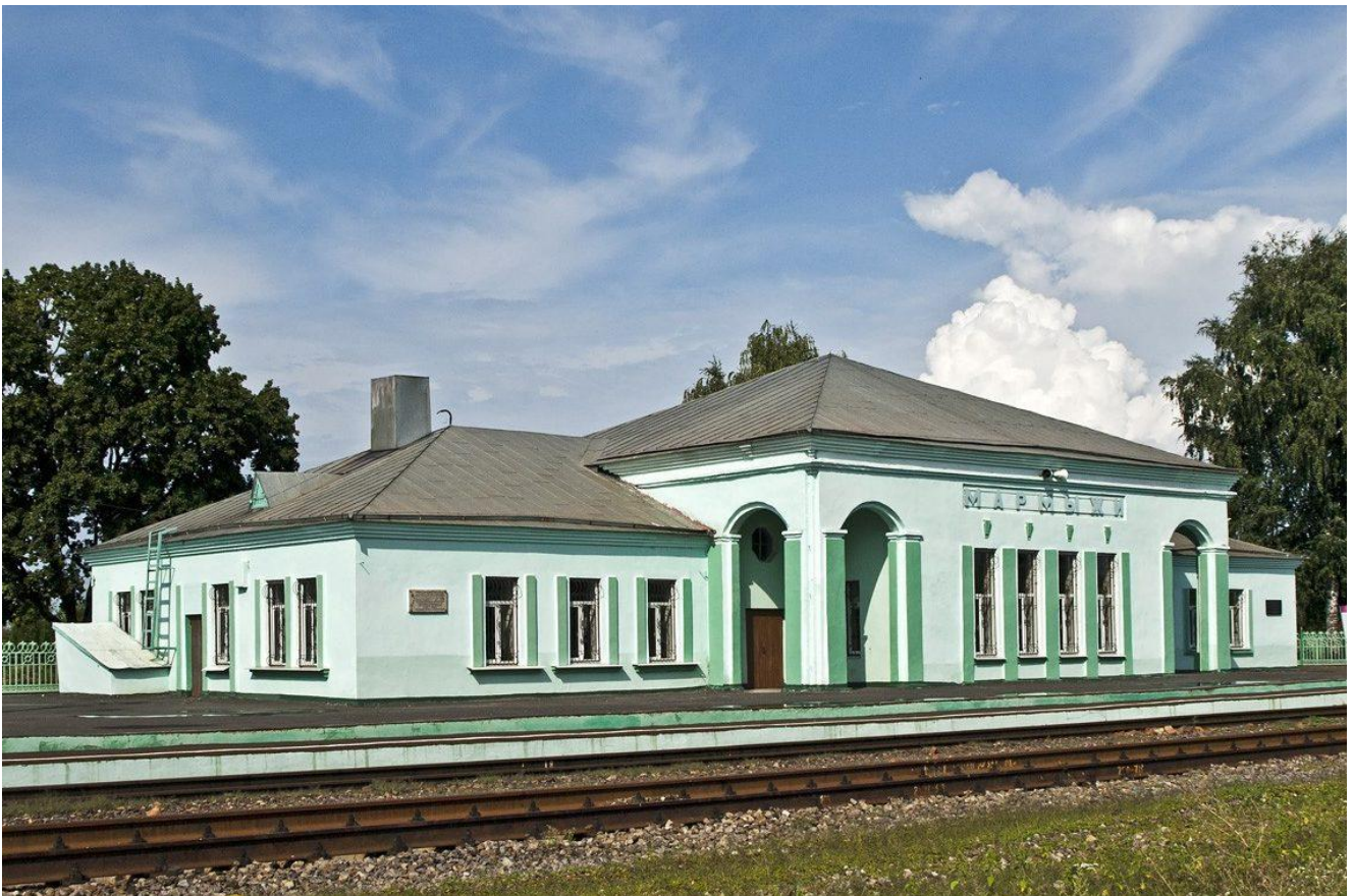
Фото: станция Мармужи
